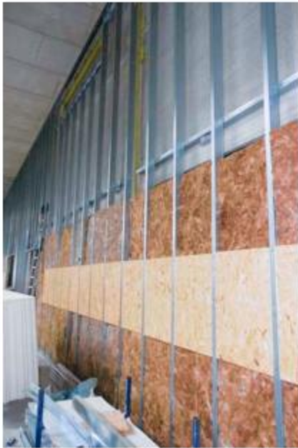
Voor alle wanden, plafonds en vloeren in het gebouw is een extra afscheiding gemaakt voor de geluidsisolatie.
